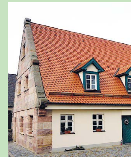
Sanierungsprojekt in Neunhof
